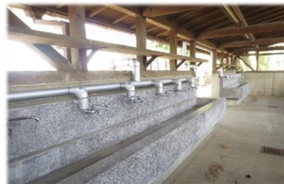
野外炊飯場の改修した水道
